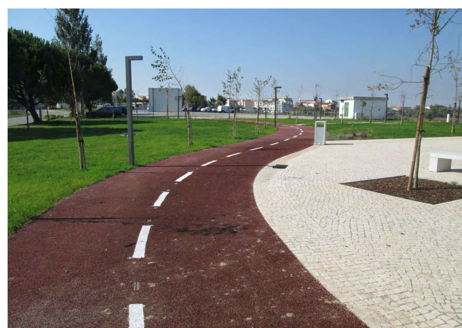
Requalificação do Espaço Público adjacente à Avenida Dr. Lúcio Vidal (ação executada)
