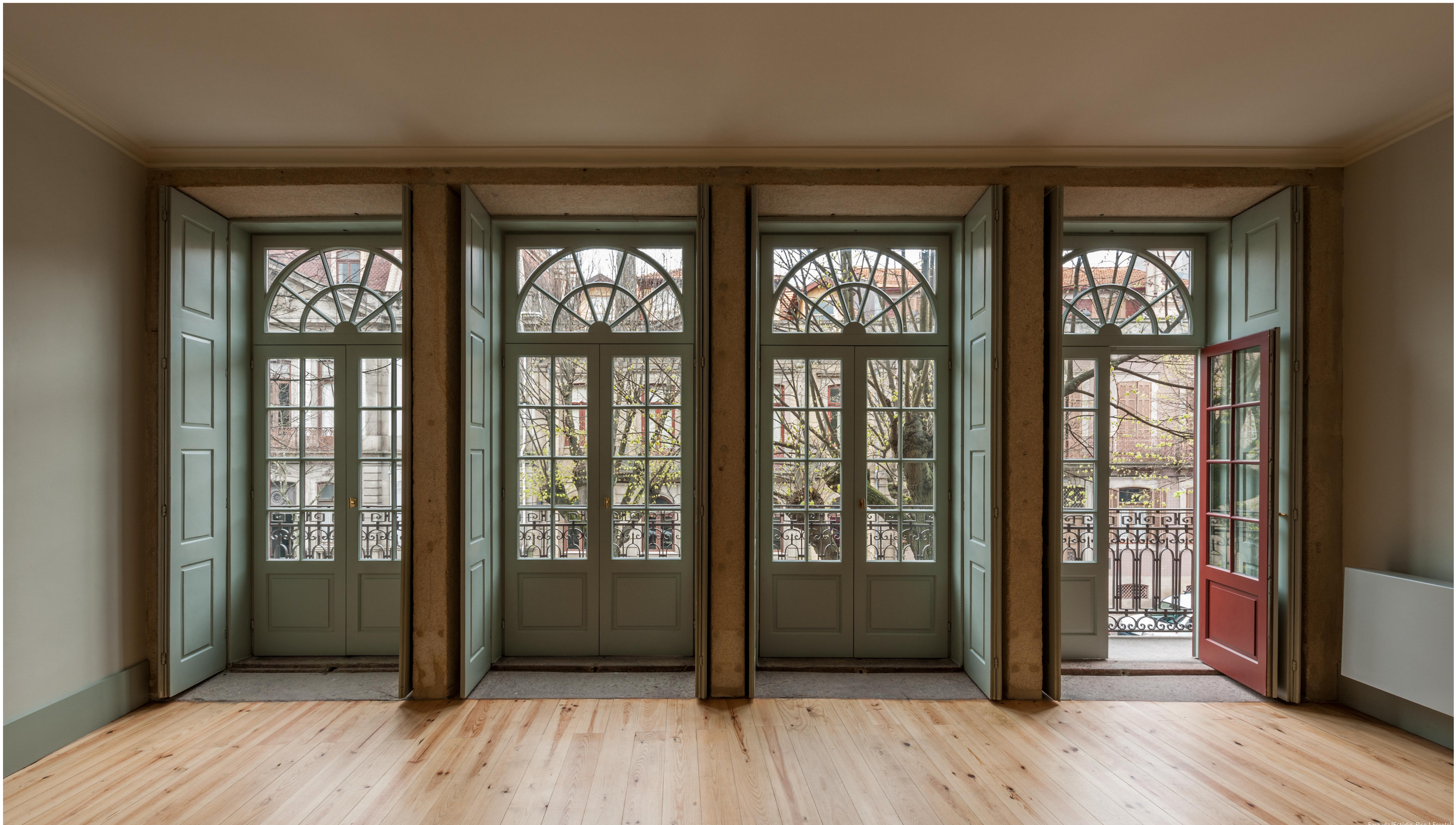
Fachada (Estúdio, Piso 1, Frente)
