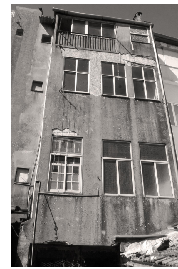
Fachada Tardoz (Antes da Intervenção)
