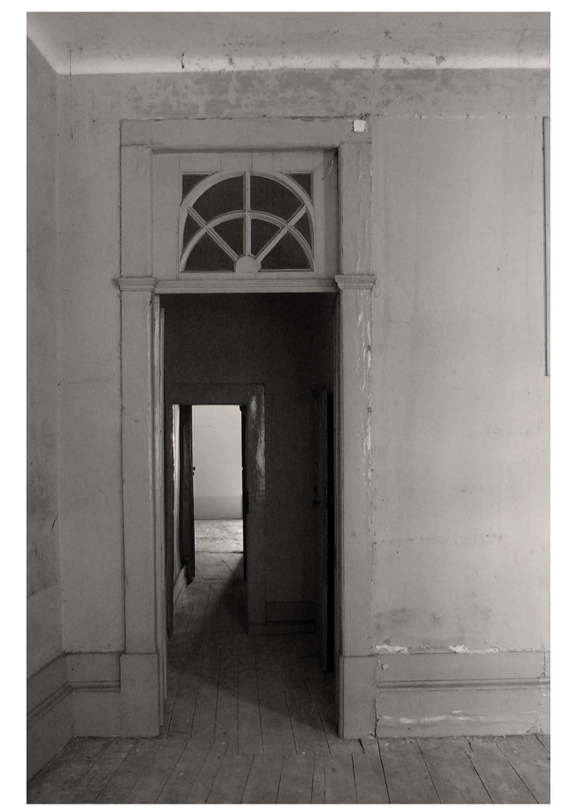
Espaço Interior (Antes da Intervenção)
