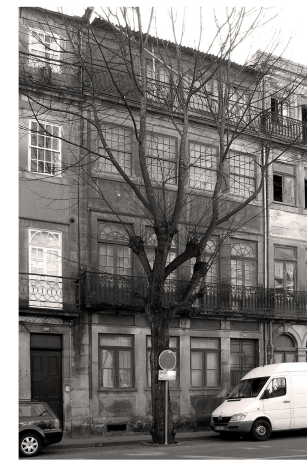
Fachada Principal (Antes da Intervenção)
