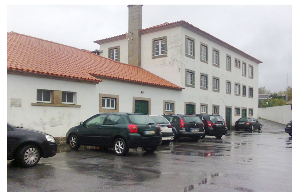
Antes da Intervenção
