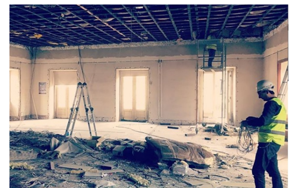
Antes da Intervenção
