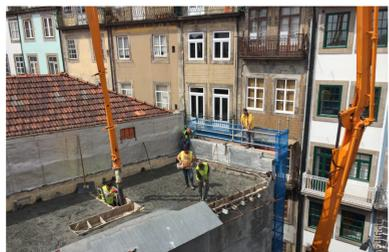
Os trabalhos efetuados foram faseados, tendo início nos Edifícios 1 e 2. Nestes, optou-se, onde possível, por um sistema construtivo baseado em estruturas de madeira, mais próximo dos métodos tradicionais de construção. Nos Edifícios 3 e 4, em face da sua reconstrução contemporânea, optou-se por um sistema baseado em lajes de betão, as quais são assumidas em pavimentos e tetos. Ainda assim, todas as caixilharias e compartimentações interiores foram executadas em estrutura de madeira.
