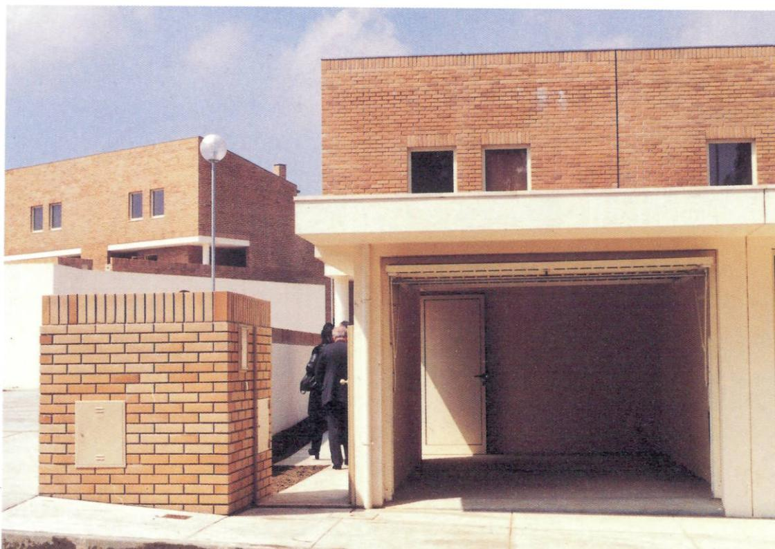
A aplicação de caixilharias em alumínio termolacado de cor branco fosco (em caixilho de bascular e de abrir) com vidro duplo.
