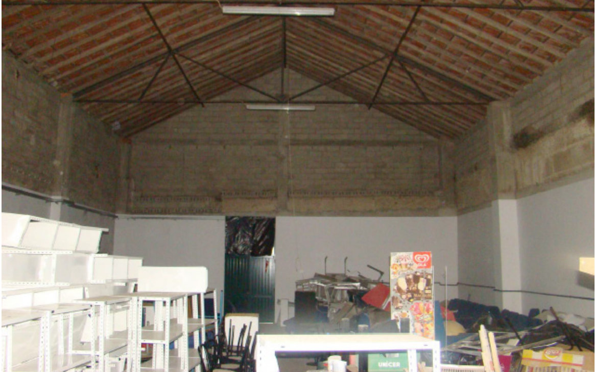
VISTA INTERIOR - SITUAÇÃO ANTERIOR
