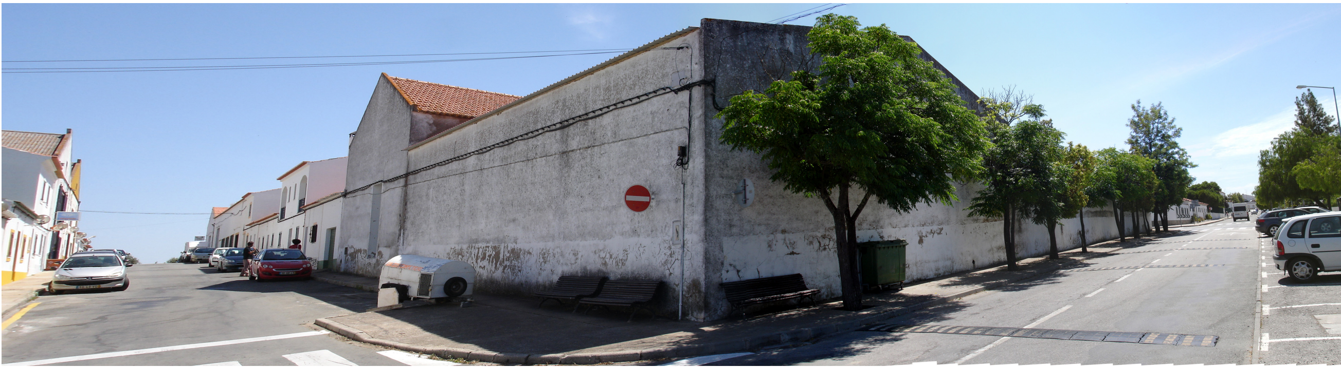
VISTA EXTERIOR - SITUAÇÃO ANTERIOR
