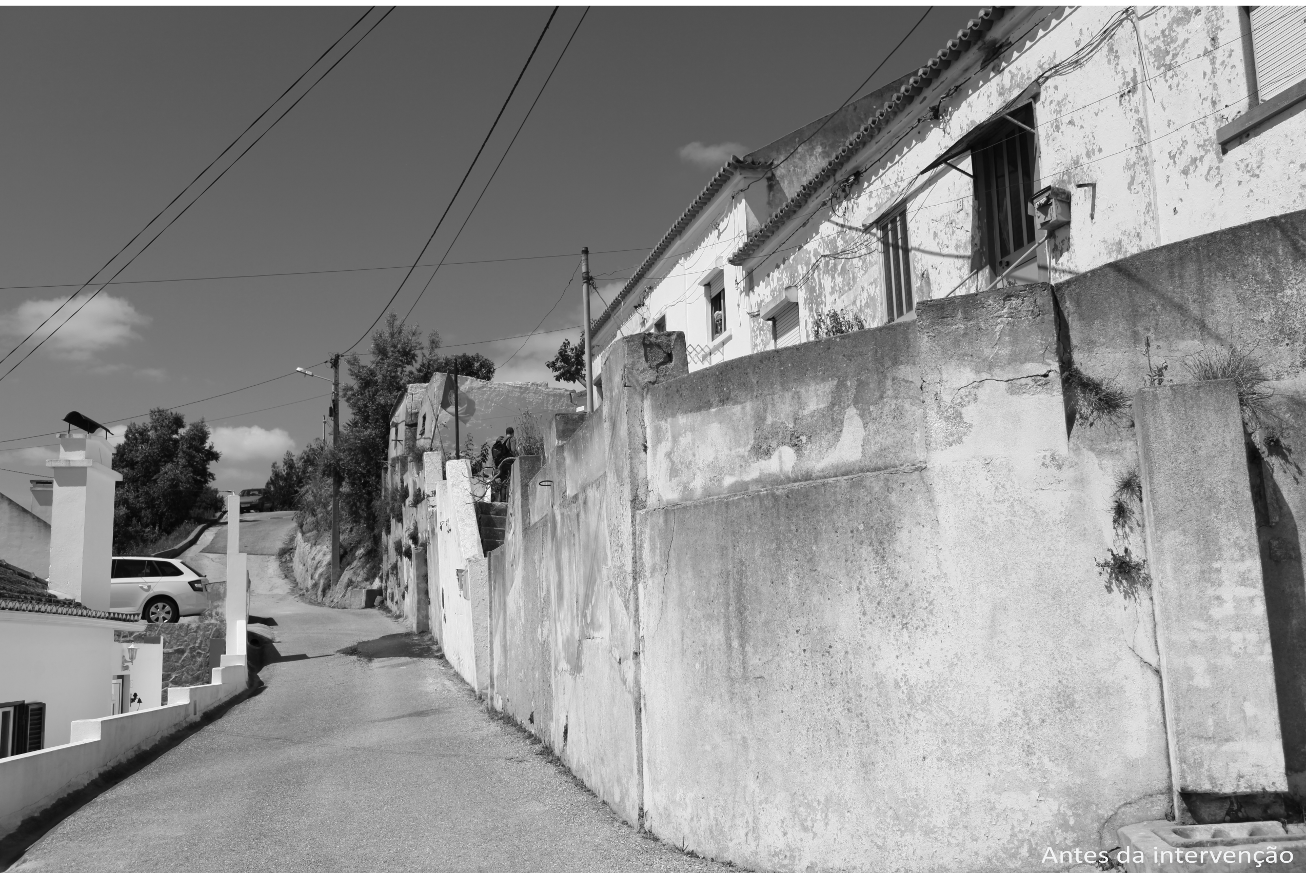
Antes da intervenção
