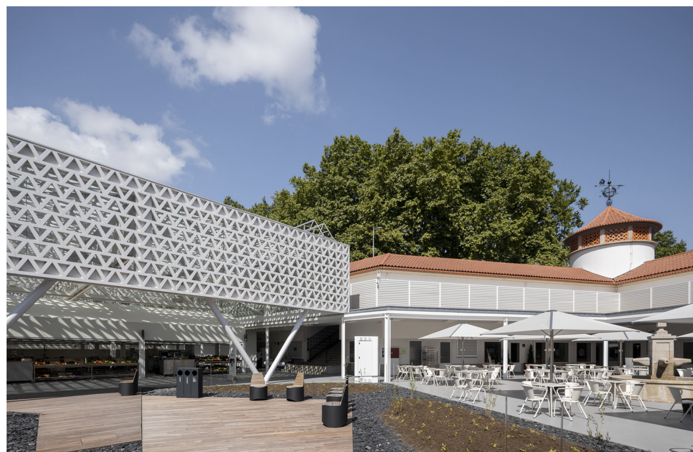
Fotografia após a intervenção
