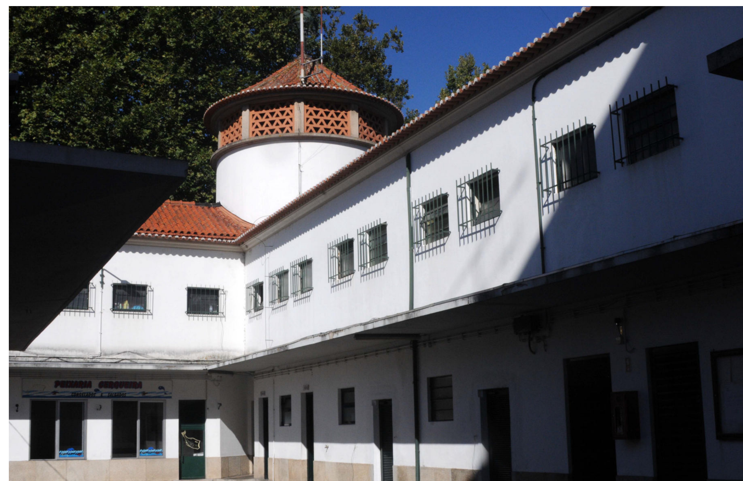
Fotografia antes da intervenção
