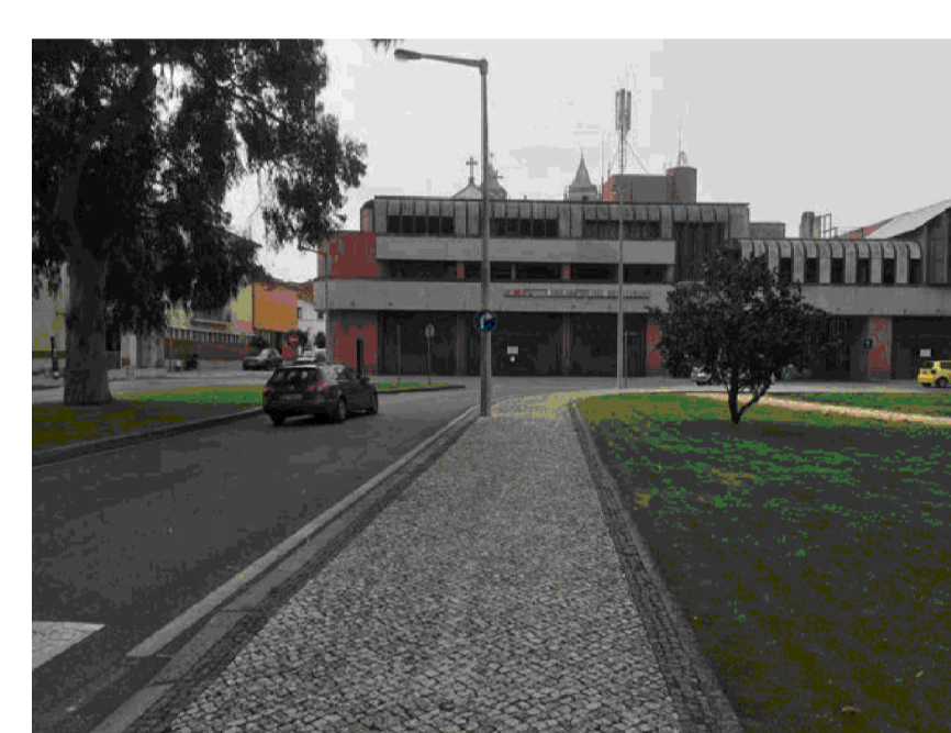
ANTES DA INTERVENÇÃO
