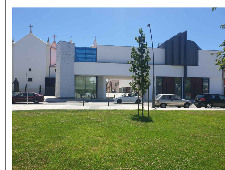
DEPOIS DA INTERVENÇÃO
